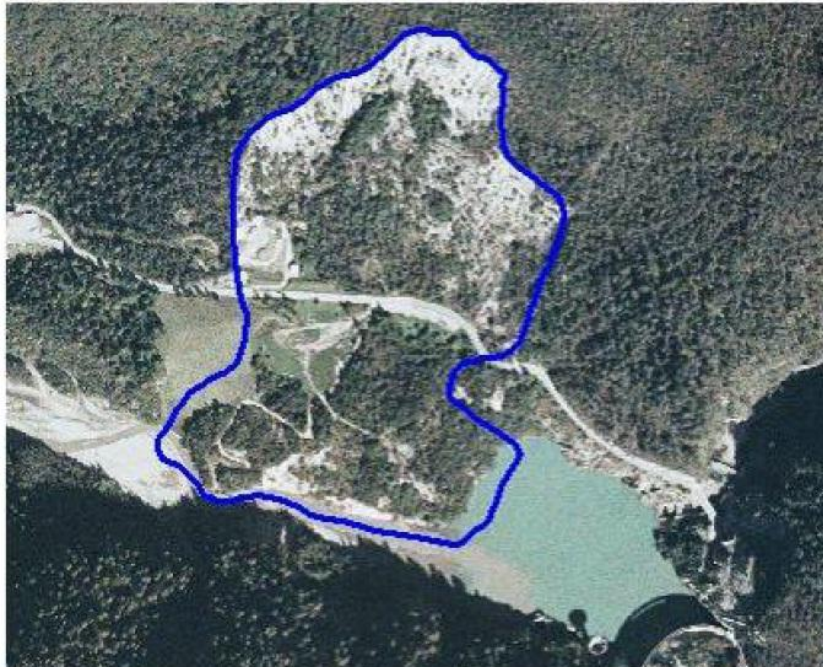
Figura 22: frana di scorrimento rototraslazionale di Pontesei in comune di Forno di Zoldo (BL). Il fenomeno franoso ha prodotto un accumulo di circa 3 milioni di mc di materiale che ha in parte colmato un bacino idroelettrico
