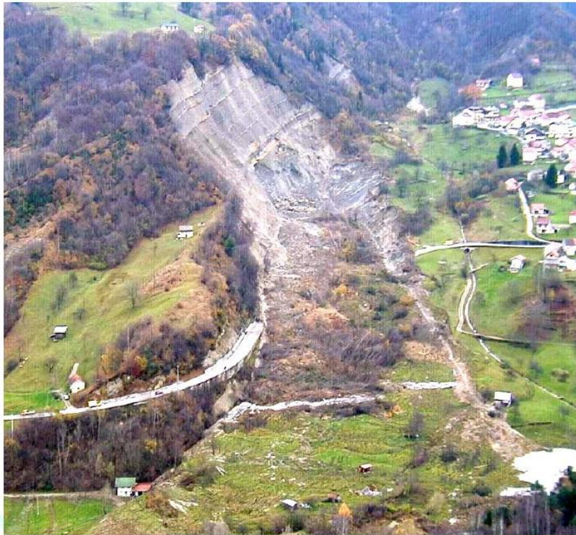
Figura 21: frana di colamento. Si tratta della frana di Borsoi in comune di Tambre (BL) che raggiunge il sottostante alveo di torrente Borsoia. Recenti riattivazioni nel 2000 e nel 2004 hanno mobilizzato volumi enormi dell'ordine di qualche milione di mc
