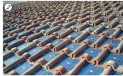
Figura 11. Esempi di pannelli fotovoltaici tra le tegole dei tetti
